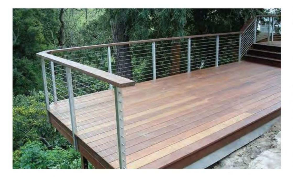
**GUARDRAILS & FENCING** METAL POST, WOOD HANDRAIL, CABLES
